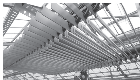
実証設備に設置した木製ブラインド
