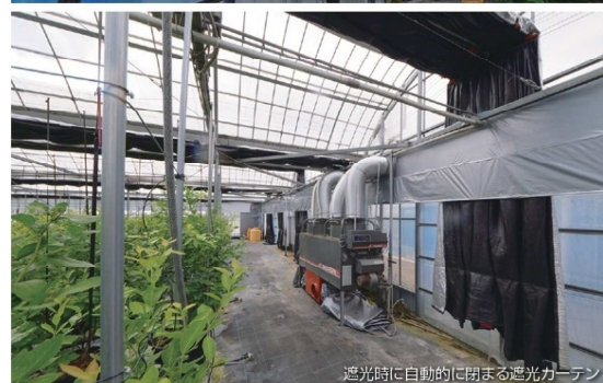
遮光時に自動的に閉まる遮光カーテン
